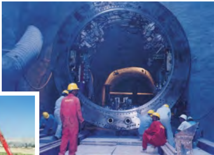
Für die Züblin International GmbH wurden Deckungen für zwei Tunnels mit dazugehörigen Nebenarbeiten für die Kanalisation und Drainage der Abwässer der Stadt Kairo/Ägypten übernommen. Ein Felstunnel ist 3,4 km lang mit einem Innendurchmesser von 4,6 m, ein weiterer Tunnel ist 1,2 km lang mit einem Innendurchmesser von 2,4 m. Die Nebenarbeiten beinhalten Straßenbauarbeiten, Versorgungsleitungen sowie fünf Schächte zwischen 10 und 30 m Tiefe. Dieses Projekt bildet den Abschluß für das Greater Cairo Wastewater Project.
