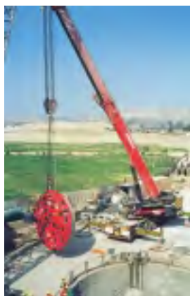
Für die Züblin International GmbH wurden Deckungen für zwei Tunnels mit dazugehörigen Nebenarbeiten für die Kanalisation und Drainage der Abwässer der Stadt Kairo/Ägypten übernommen. Ein Felstunnel ist 3,4 km lang mit einem Innendurchmesser von 4,6 m, ein weiterer Tunnel ist 1,2 km lang mit einem Innendurchmesser von 2,4 m. Die Nebenarbeiten beinhalten Straßenbauarbeiten, Versorgungsleitungen sowie fünf Schächte zwischen 10 und 30 m Tiefe. Dieses Projekt bildet den Abschluß für das Greater Cairo Wastewater Project.
