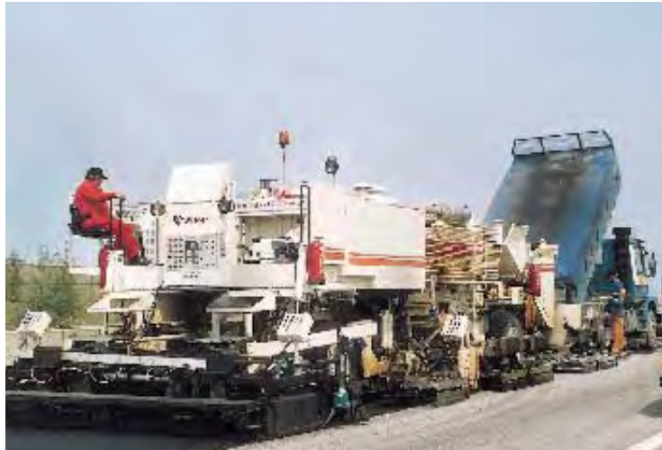
Lieferung eines Wirtgen-Remixers an die Stadt Almaty, Kasachstan. Mit dem Straßenrecycler werden bituminöse Fahrbahnen instandgesetzt. Der vorhandene Straßenbelag wird dabei vollständig wiederverwertet.
