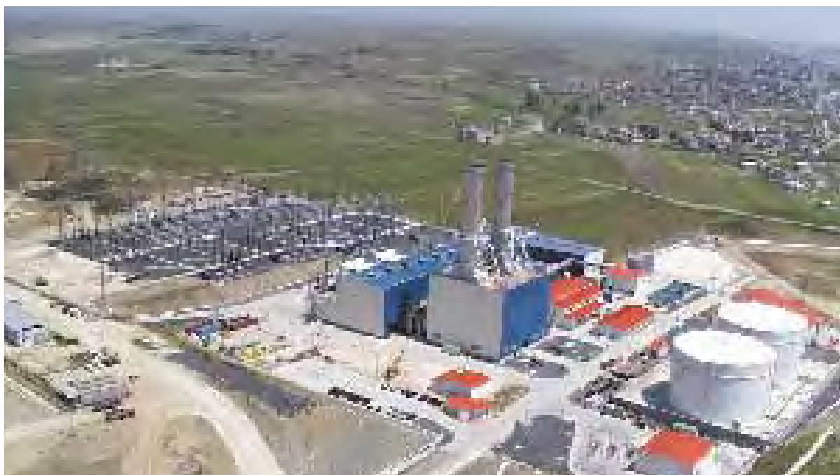
Im Rahmen einer Projektfinanzierung errichtete die ABB Kraftwerke AG, Mannheim, für ihren Kunden UNI-MAR Enerji Yatirimlari A.S. nahe der türkischen Stadt Marmara Ereglisi ein schlüsselfertiges, gas- und ölbefeuertes Kombikraftwerk mit einer Kapazität von 490 MW. Beim deutschen Finanzierungsvolumen beträgt der Lieferanteil aus den neuen Bundesländern mehr als 40 %. Kraftwerke dieser Bauart gelten aufgrund der niedrigen Emissionswerte als besonders umweltfreundlich. Da das Kraftwerk in einem erdbebengefährdeten Gebiet liegt, wurde es erdbebensicher konstruiert. Es hat das schwere Erdbeben im August 1999 ohne Schäden überstanden und befindet sich seit Juni 1999 mit hoher Verfügbarkeit in kommerziellem Betrieb.
