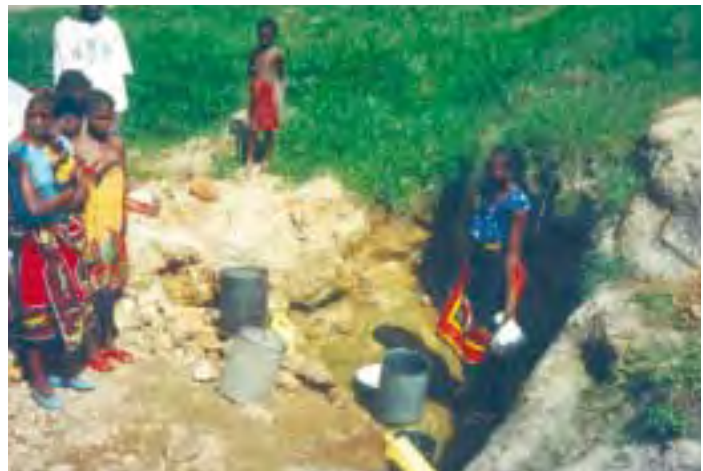
Mosambik: Nach der Flut ist die Wiederherstellung der vorhandenen Trinkwasserbrunnen lebenswichtig.
