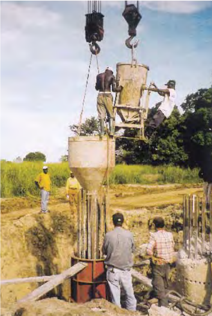
Bau einer 850 m langen Brücke über den Rufiji Fluß und von Zubringerstraßen durch ein 14 km langes Überschwemmungsgebiet in Tansania. Bisher konnte der Rufiji Fluß nur mit Hilfe einer kleinen Fähre überquert werden - aufgrund des jährlichen Hochwassers war diese jedoch nur neun Monate im Jahr im Betrieb. Das Infrastrukturprojekt hat eine große Bedeutung für die wirtschaftliche Entwicklung der Region. Planung und Überwachung des Projekts durch H.P. Gauff Ingenieure GmbH & Co.
