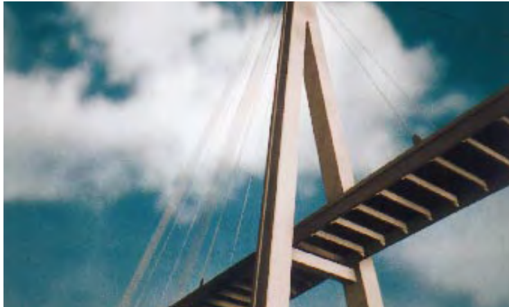
Neubau einer 485 m weiten Schrägseilbrücke in Kroatien über den Fluß Dubrovacka bei Dubrovnik. Das in Zusammenarbeit mit kroatischen Bauunternehmen gestaltete Infrastrukturprojekt der Firma WALTER BAU AG fördert den wirtschaftlichen Wiederaufbau Kroatiens.
