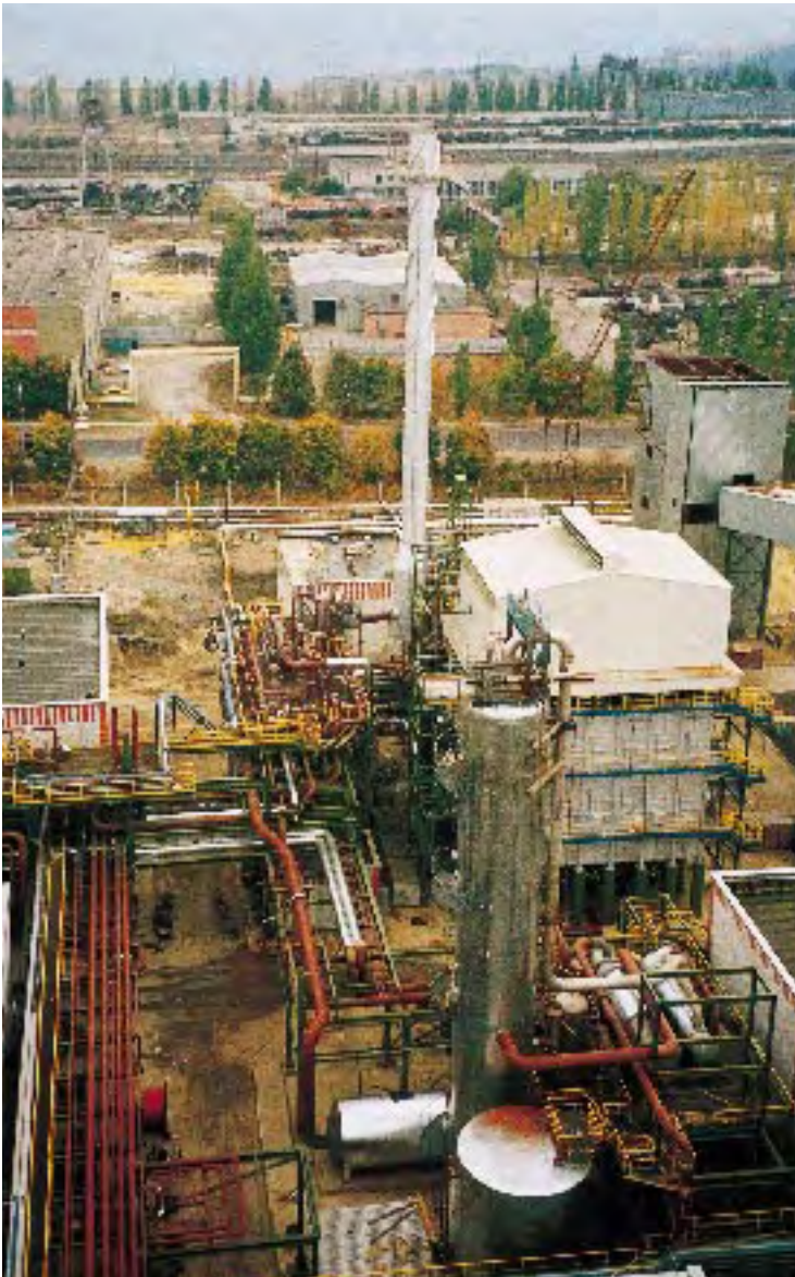
In Gubkin, Rußland R.F., erstellt das Konsortium Klöckner INA/Ferrostaal eine Anlage zur Herstellung von metallisierten Eisenerzbriketts. Das Projekt umfaßt neben Engineering, Lieferungen, Montageüberwachung und Inbetriebnahme auch die Schulung der Mitarbeiter sowie eine technische Assistenz nach Betriebsbereitschaft der Anlage.
