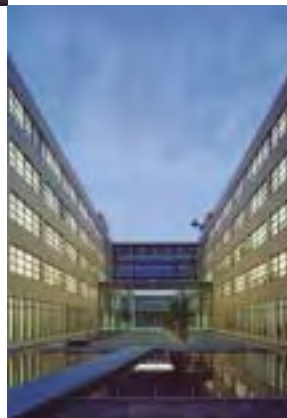
Etwa 400 Mitarbeiterinnen und Mitarbeiter der mit der Bearbeitung der Ausführungsgewährleistungen beauftragten Mandatargesellschaften HERMES Kreditversicherungs-AG und PwC Deutsche Revision Aktiengesellschaft zogen am 1. Juli 2001 in ein neues Verwaltungsgebäude ein.
