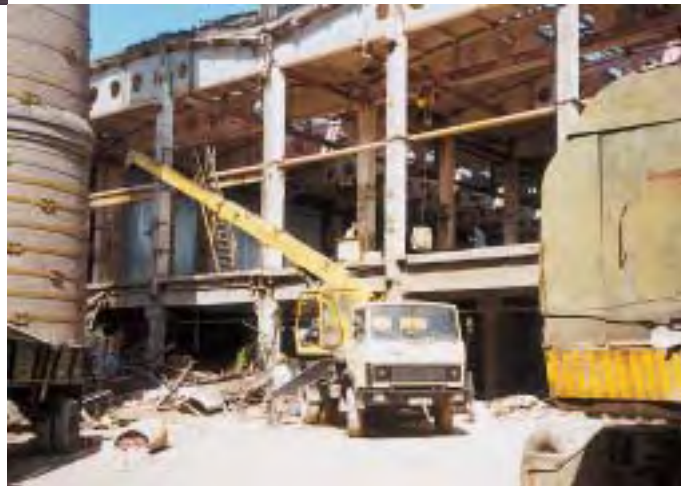
Engineering, Lieferung und Errichtung einer kompletten Anlage zur Herstellung von Glas-seide – inklusive Ersatz- und Verschleißteile – durch die Projektierung und Anlagenbau GmbH, Bautzen. Der weitestgehende Anteil der Lieferungen stammte aus den neuen Bundesländern. Die Errichtung der Anlage in Usbekistan erfolgte in der vorhandenen Bauhülle eines produzierenden Glaswerkes.
